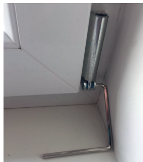
Seiteneinstellung am Ecklager
