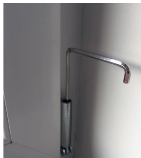
Höheneinstellung am Ecklager
